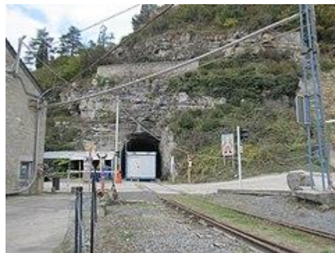
Tunnel côté carrière
